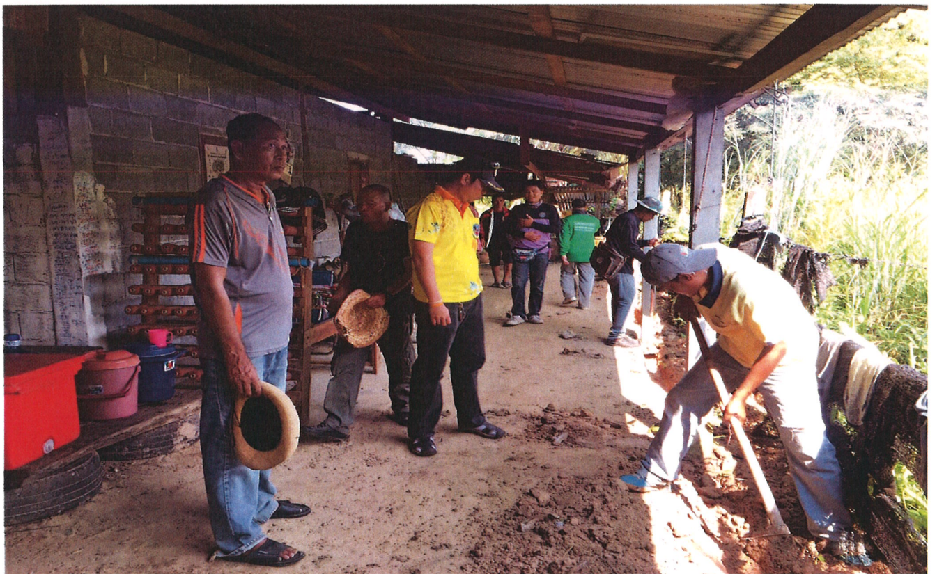
โครงการปรับปรุงซ่อมแซมบ้านผู้พิการ รายนางถาวร บรรณณี หมู่ที่ ๑
